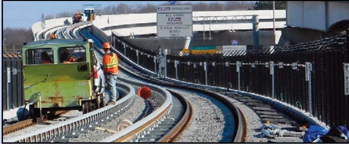
EN EL CARRIL-GUÍA DE TYSONS OESTE HACIA EL NORESTE: Construcción de paredes, la tierra debajo de las vías, las vías, y las cercas de seguridad está terminado. Foto por Stephen Barna, Proyecto del Metrorail de Corredor Dulles.
