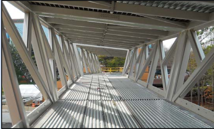
DENTRO A UN PUENTE DE PEATÓN EN LA ESTACIÓN WIEHLE: Los arcos de los puentes de peatón se han levantado y esperan finalización de interior y exterior. Foto por Stephen Barna, Proyecto del Metrorail de Corredor Dulles.
