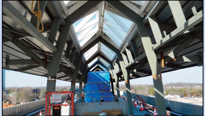
EN LA ESTACION SPRING HILL (TYSONS OESTE): El armazón para el toldo de la Estación Spring Hill está terminado. Foto por Stephen Barna, Proyecto del Metrorail de Corredor Dulles.
