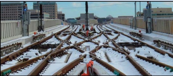
INVIERNO: La reciente nieve encima de las pistas en la mediana de la Ruta 7. Foto por Chuck Samuelson, Dulles Corridor Metrorail Proyecto
