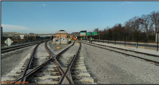
Trabajadores configurando el cruce de vías en la Estación Innovation Center. (Cortesía de John Kearney)
