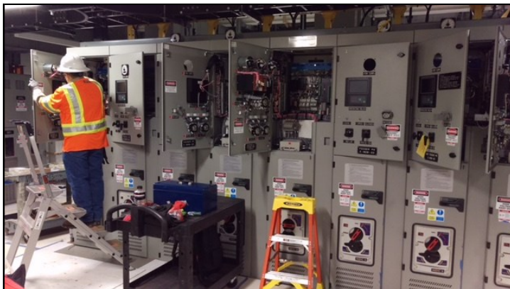
Dentro de un edificio de TPSS trabajando para conectar el cableado interno despues de que la construccion modular se levanto en el sitio. (Cortesia de John Kearney)
