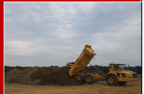
Foto cortesía de proyecto de Metrorail del corredor de Dulles
