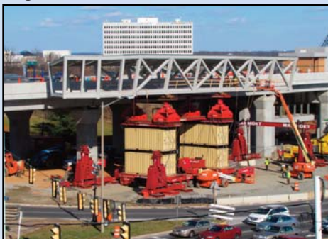
Listo Para Levantar: Equipos preparan para la ubicación de segmentos del puente de peatón en la Estación de Tysons Corner. Foto por Chuck Samuelson, El Proyecto de Metrorail del Corredor Dulles.
