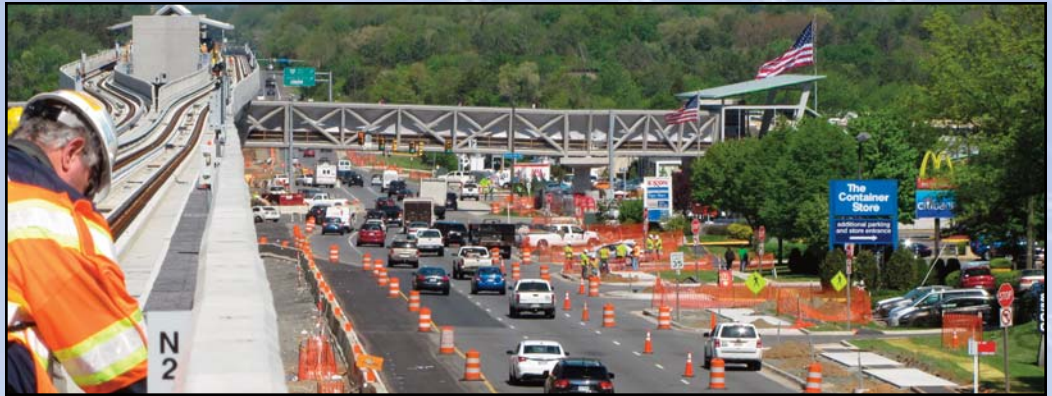
Los Últimos Toques: Equipos trabajan a lo largo del carril-guía aéreo mientras otros preparan para las aceras a lo largo de los carriles hacia el oeste de Ruta 7. Foto por Chuck Samuelson, Proyecto de Metrorail de Corredor Dulles
