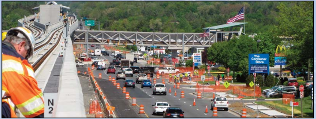
Los Últimos Toques: Equipos trabajan a lo largo del carril-guía aéreo mientras otros preparan para las aceras a lo largo de los carriles hacia el oeste de Ruta 7. Foto por Chuck Samuelson, Proyecto de Metrorail de Corredor Dulles
