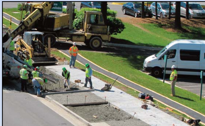
Indicios de Aceras: Equipos del Riel Dulles están continuando a construir aceras y crear lugares para las plantas y los faroles a lo largo de Ruta 7. Los faroles instalarán más tarde por Dominion Virginia Power. Foto por Chuck Samuelson, Proyecto de Metrorail de Corredor Dulles
