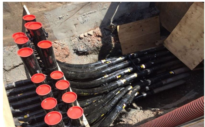
En la foto de arriba son tubos de PVC, que se encuentra a más de 10 pies bajo tierra en una zanja, que sólo albergan algunas de la alimentación eléctrica necesaria para vagones de tren de potencia en la estación de Herndon. Foto por: Stacey DaBaldo, MWAA Intern para el Proyecto Corredor Dulles Metrorail.
