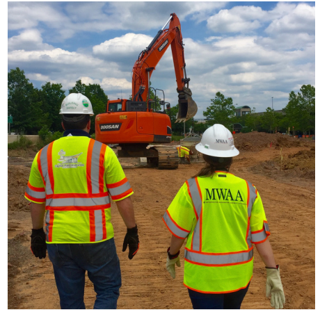
Encargado de la construcción, Nick Perrota de capitales tren de constructores y Stacey DaBaldo del Proyecto del Corredor del Metrorail Dulles, recorrer la estación TPSS 13 situado al oeste de la estación de tren o Monroe Herndon. Foto por: Lisa Sheffer de Dulles Metrorail Proyecto Corredor.
